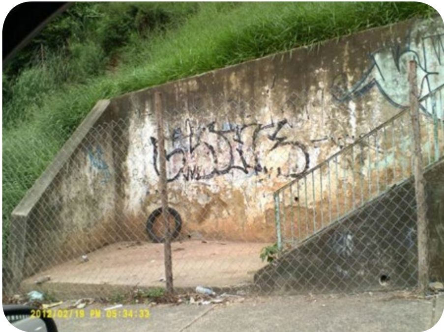
Entrada lateral esquerda pela Rua Vigário J. J. Rodrigues Fonte: acervo da autora
