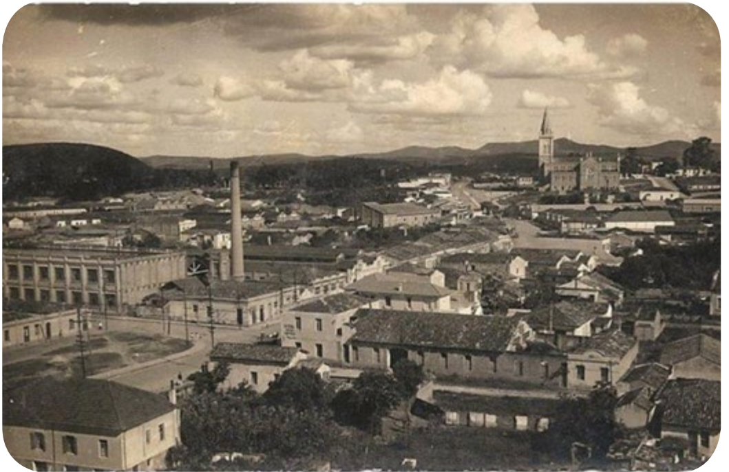
Fotos tiradas do mesmo ângulo mostrando o desenvolvimento do Bairro da Vila Arens – Vistas do Morro do Grupo Fonte: Acervo Centro de Memória de Jundiáí.
